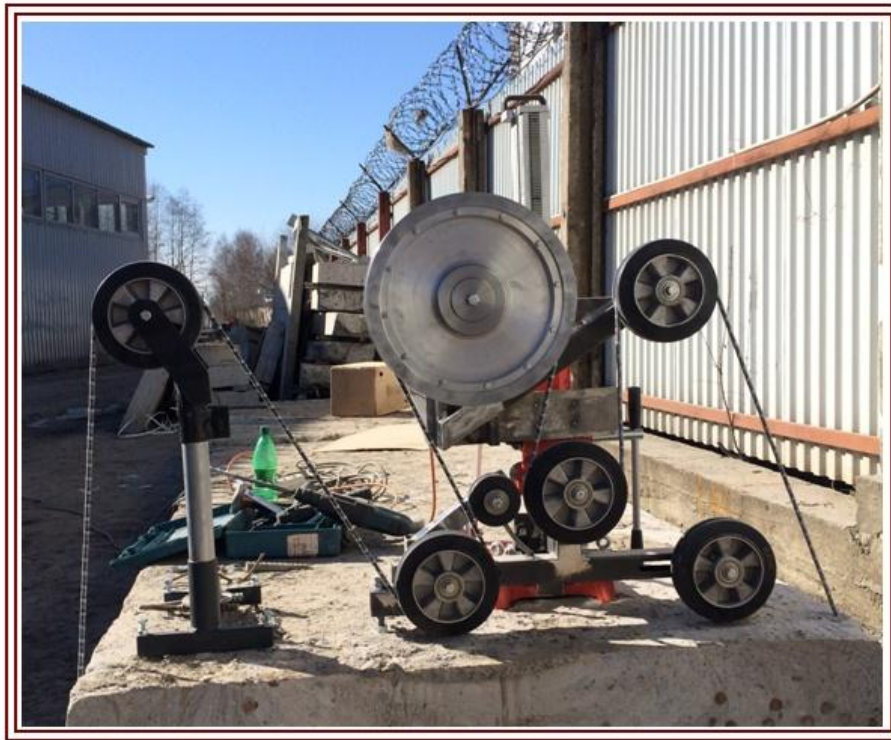
Рис .5.18. Резка с применением дополнительного ролика на стойке
